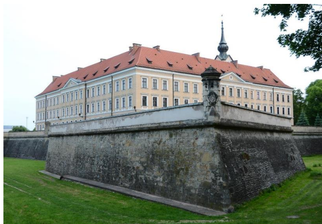
Fotografia 14. Widok na zamek Lubomirskich [13].
